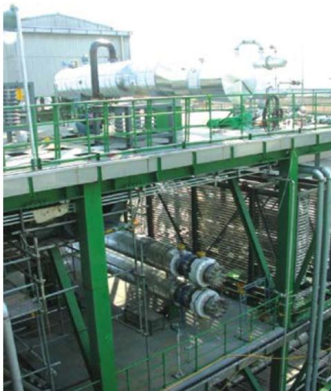
Рисунок 1.6 - Промышленная установка окисления водного стока производства терефталевой кислоты фирмы «Samnam Petrochemical Company, Ltd.», осуществляемого в СКФ условиях (СКВО) [178]
