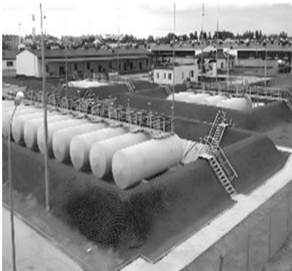
Рис. 1. Обвалование резервуаров горизонтальных стальных (РГС)
