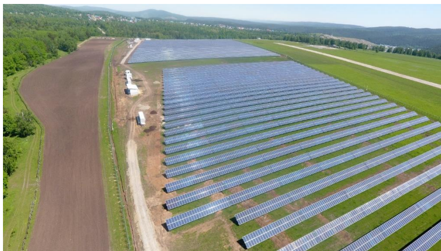
Рис. 5. Бурзянская СЭС мощностью 10 МВт со встроенной системой накопления электроэнергии ёмкостью 8 МВт·ч
