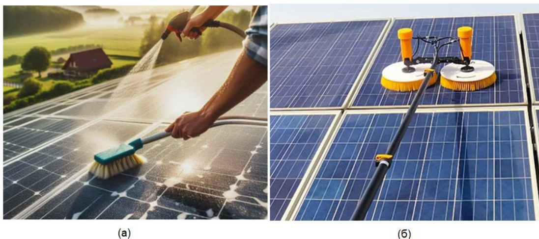
Рис. 1. Ручной (а) и полуавтоматический (б) способ очистки СП
