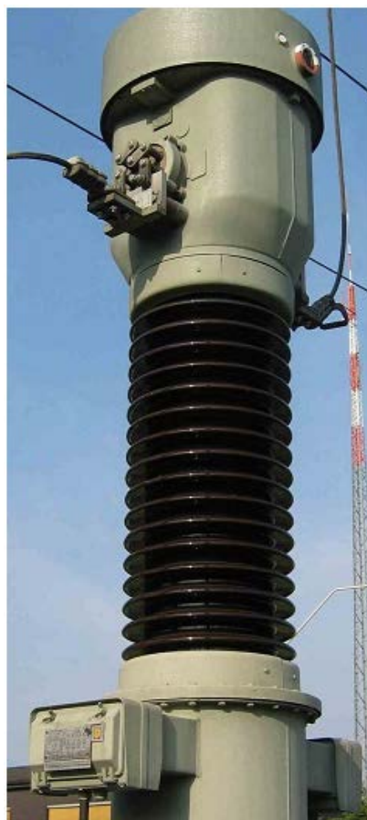
Рис. 1. Сильфонный расширитель
