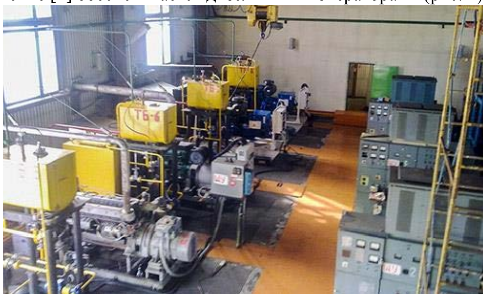
Рис. 2. ДЭС для энергоснабжения отдаленных населенных пунктов
