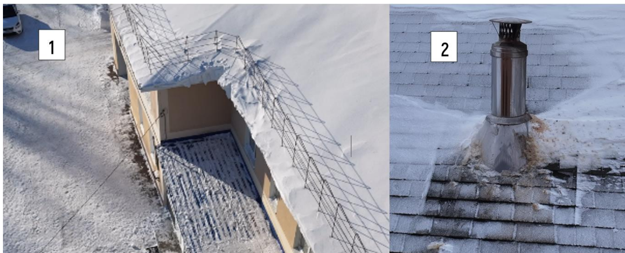
Рис. 2. Пример проведения визуального обследования: 1 – контроль снеговой «шапки» на кровле; 2 – контроль эксплуатации дымоходной трубы отопления на скатной кровле.
