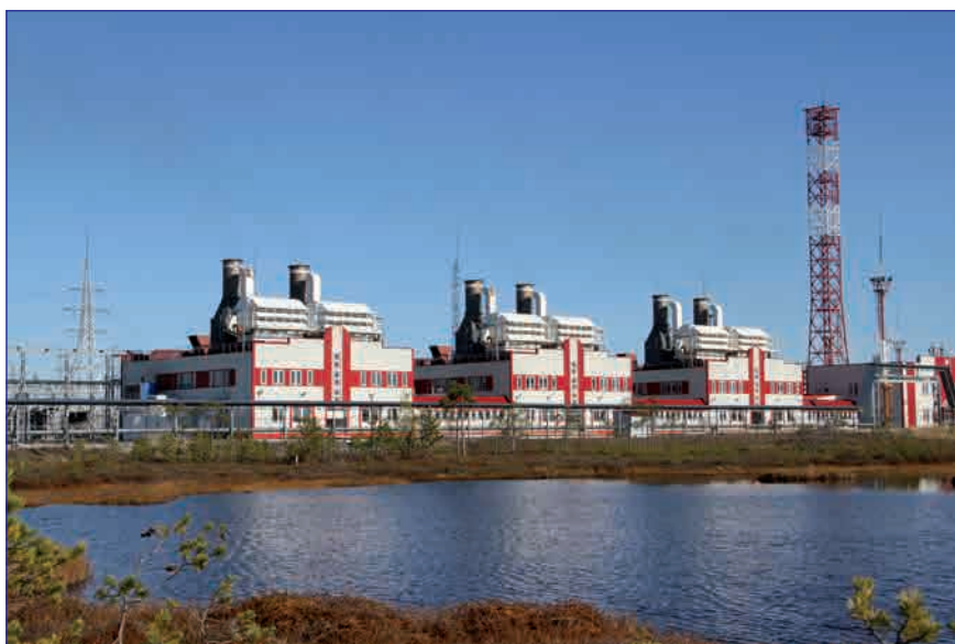
Ватьеганская ГТЭС-72 ООО «ЛУКОЙЛ-Западная Сибирь» на базе пермских ГТУ-12ПГ-2
