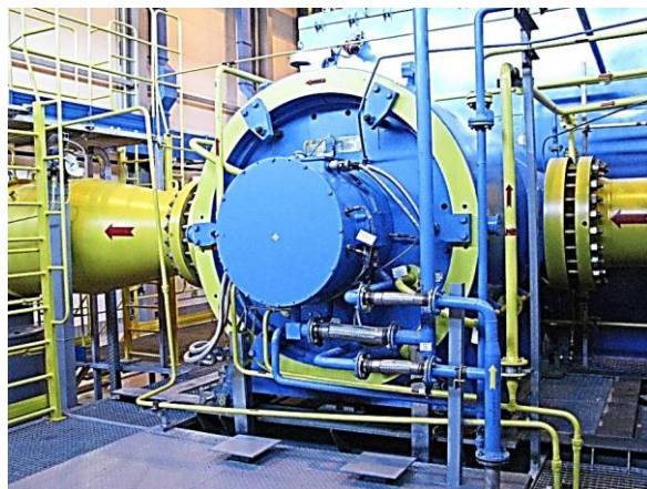
Рис. 2. Центробежный компрессор с АМП
